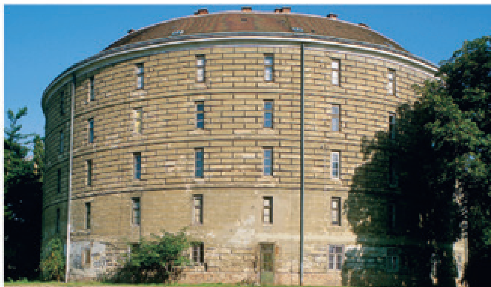
BALRA Az 1784-ben, a Közkórház mellett épült bécsi Narrenturm. A külön épület a pszichés betegekhez való újfajta hozzáállás megjelenését jelzi
